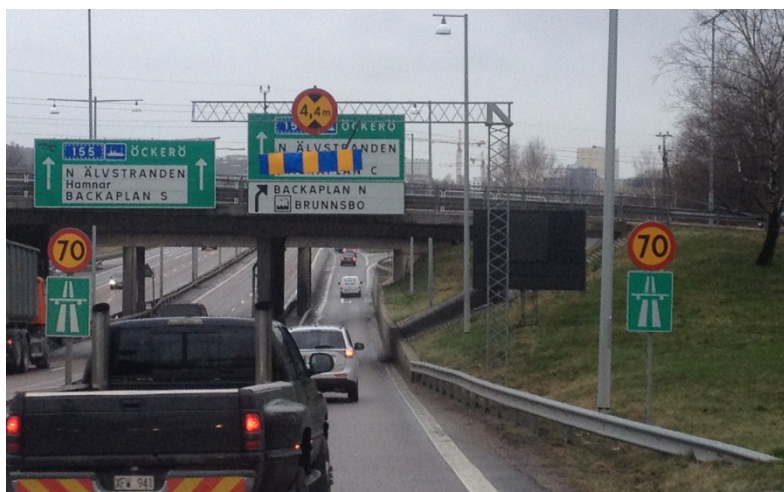
Foto 2. Sänkning av Lunbyleden under Brunnsbomotet och järnvägsbron
